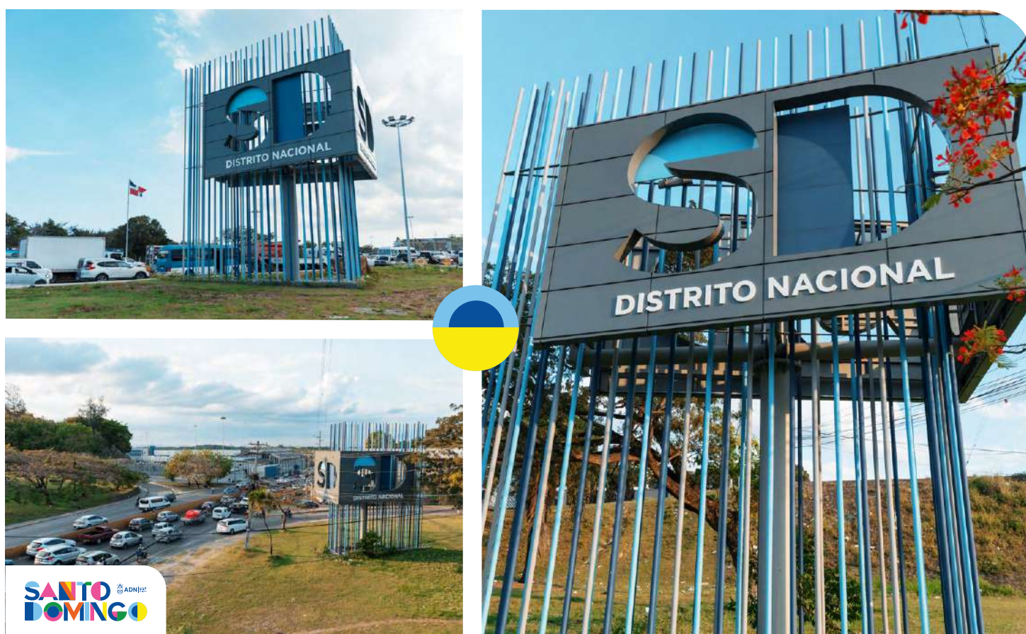
Entradas La Zurza y Kilómetro 9 de la autopista Duarte
